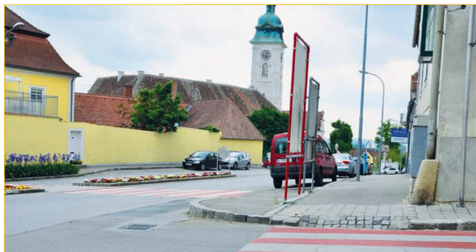
Gehsteigabschrägung für Kinderwagen und Rollstühle
