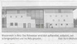
Wasserwerk in Retz. Das Rohwasser wird dort aufbereitet, entsinkt, zwischengespeichert und ins Netz gespeist.
